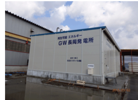
FIT ID 取得発電所
