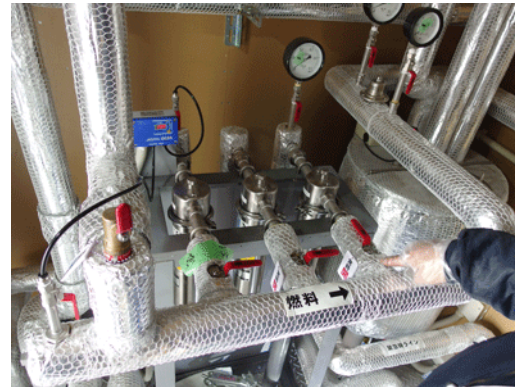
制御されたシステム設計施工
